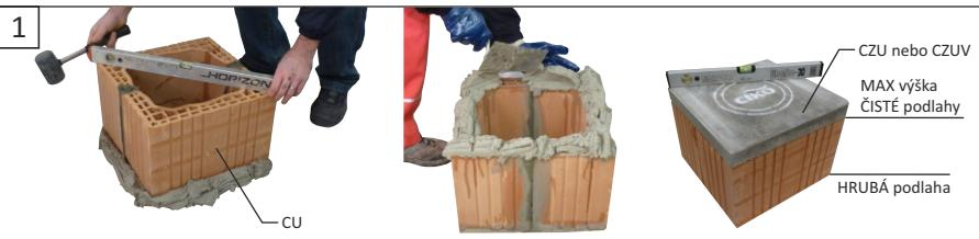
Na hrubé podlaze a hydroizolaci usadíme do lože z obyčejné zdí malty (není součástí dodávky) první pár tvarovek CU a vyravnáme do vodorovny. Opět na obyčejné zdí maltu usadíme zakládací prvek CZU nebo CZUV a vyravnáme do vodorovny.
